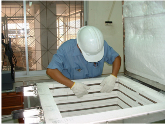
รูปที่ 4 การวางขดลวดความร้อน
