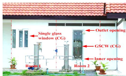
รูปที่ 3 ตำแหน่งการติดตั้ง GSCW (Room 2) บนผนังของบ้านด้านทิศใต้ และหน้าต่างกระจกใส CG (Room 1)
