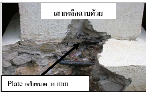
รูปที่ 5 ปลายเสาที่ถูกทุบสกัดเพื่อตรวจสอบรายละเอียดการต่อปลายเสาและตอม่อ
