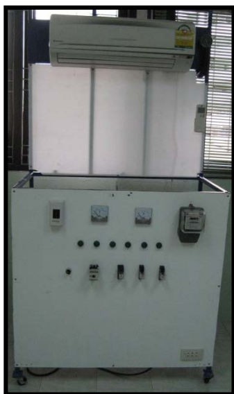
รูปที่ 5 การติดตั้งระบบทำความเย็น
