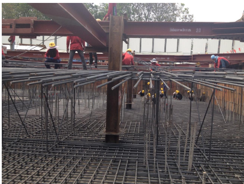
รูปที่ 4 การทำงานเหล็กเสริมในฐานรากคอนกรีต
