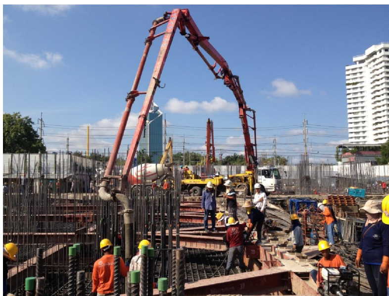
รูปที่ 10 การเทคอนกรีตผ่านปั๊มคอนกรีต
