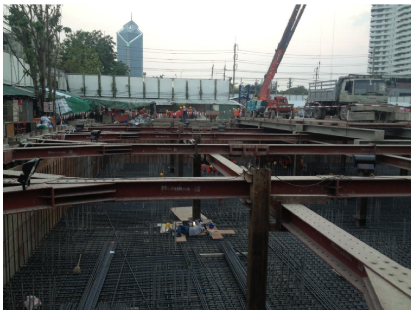
รูปที่ 3 โครงสร้างระบบค้ำยันเข็มพีค (Sheet pile bracing system)
