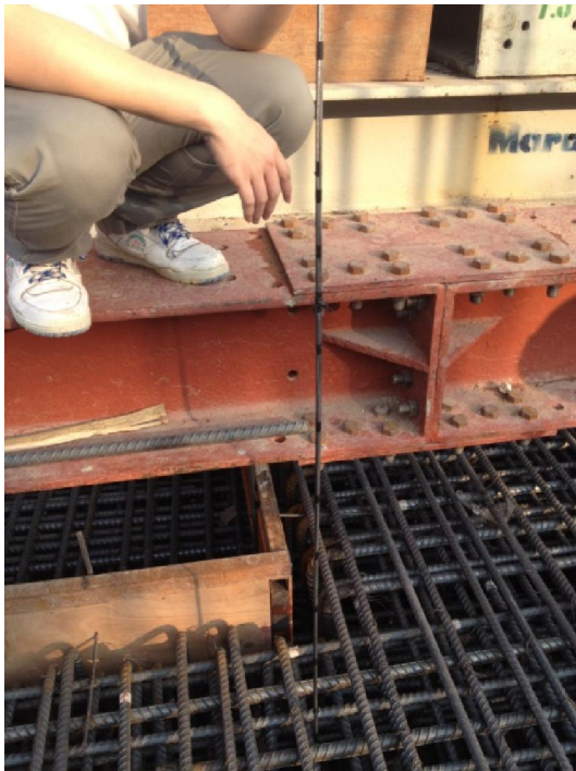
รูปที่ 7 การติดตั้งเครื่องวัดอุณหภูมิในฐานรากคอนกรีต
