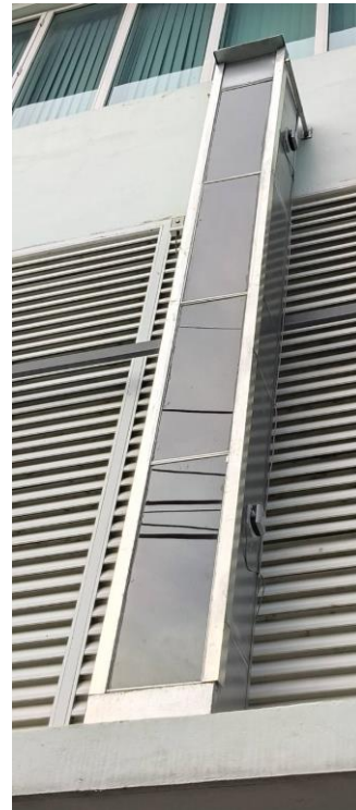
รูปที่ 2 การติดตั้งปล่องรังสีอาทิตย์โซลาร์เซลล์ขนาดใหญ่ ทางทิศใต้ของอาคาร
