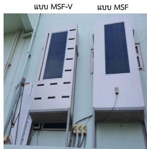
รูปที่ 5 การติดตั้งผนังเปลือกอาคาร (facade) แบบไม่เจาะช่อง (MSF) และแบบเจาะช่อง (MSF-V) ทิศตะวันตกเฉียงใต้ของอาคาร
