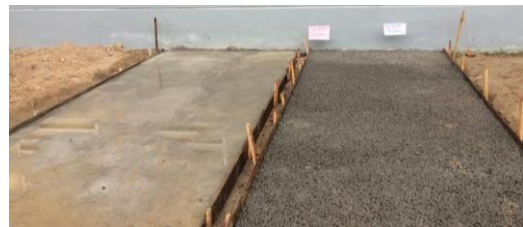
รูปที่ 14 พื้นคอนกรีตทั่วไปและพื้นคอนกรีตพรุน
