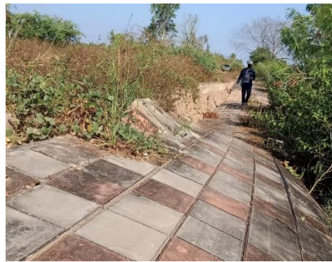
รูปที่ 12 ความเสียหายของเชื่อนป้องกันตลิ่งที่บ้านนาเช ต.นาเช อ.บ้านแพง จ.นครพนม
