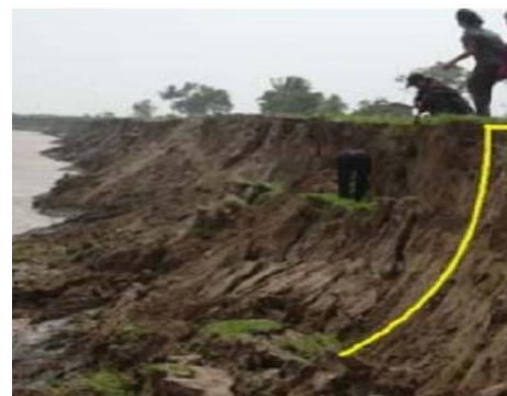
รูปที่ 10 การพิบัติของตลิ่งบ้านดอนนางหงส์ อ.ธาตุพนม จ.นครพนม [5]
