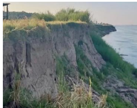
รูปที่ 9 การพิบัติของตลิ่งบ้านคอนแพง ต.บ้านแพง อ.บ้านแพง จ.นครพนม
