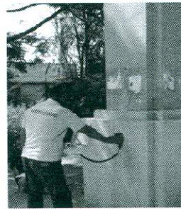
รูปที่ 1 การหาตำแหน่งเหล็กเสริมและการวัดระยะหุ้มเหล็กเสริมของโครงสร้างสะพานลอย
