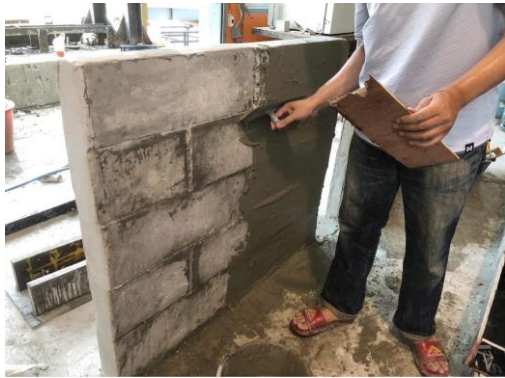
รูปที่ 16 การก่อ-ฉาบผนังเฮมพ์กรีตด้วยปูนฉาบปกติ
