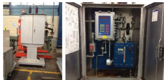
รูปที่ 1 ระบบหล่อลื่นแบบละอองน้ำมัน
