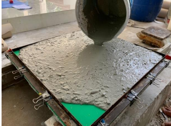
รูปที่ 5 การเทส่วนผสมทั้งหมดให้เต็มแบบหล่อ
