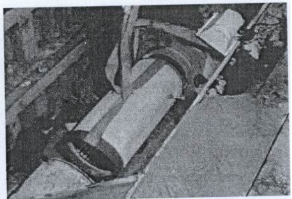
รูปที่ 11 การดันท่อกอนกรีตที่มีท่อเหล็กเป็นท่อกว้างใน
