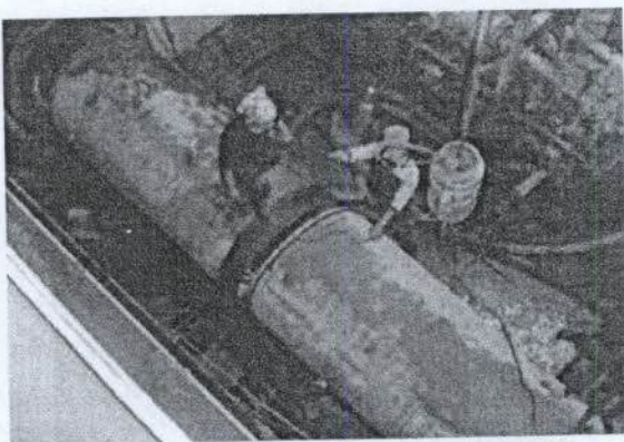
รูปที่ 10 การดันท่อเหล็กเหนียวสองชั้น
