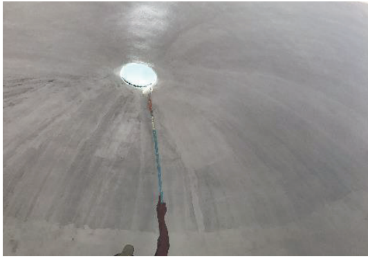
รูปที่ 18 การทำสีผนังอาคารสำเร็จรูปทรงกลม
