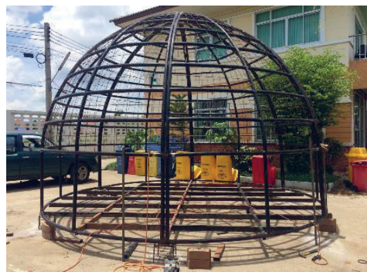
รูปที่ 6 โครงสร้างอาคารสำเร็จรูปที่พร้อมสำหรับการหล่อและฉาบเปลือกอาคาร
