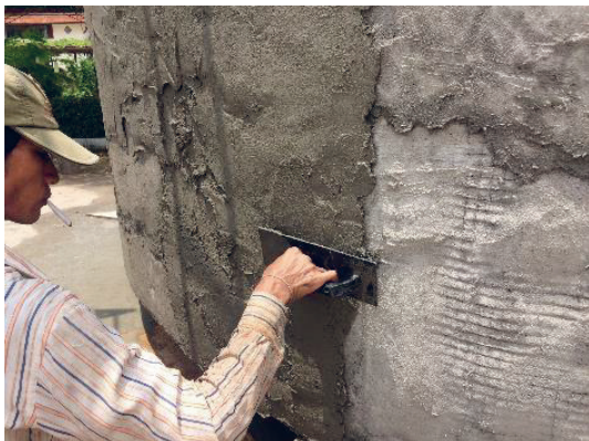
รูปที่ 8 ฉาบส่วนผสมในแบบที่มีการติดตั้งตะแกรงเหล็ก
