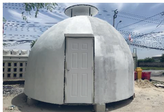
รูปที่ 17 ด้านหน้าอาคารสำเร็จรูปครึ่งทรงกลม ก่อนทาสี
