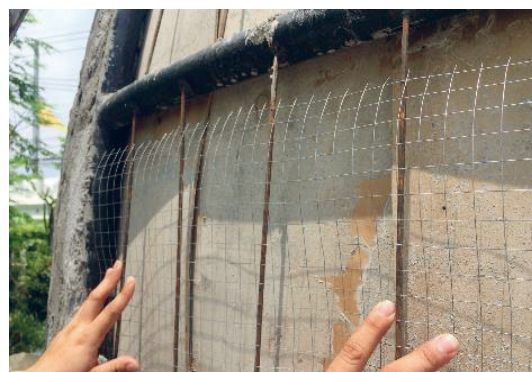
รูปที่ 7 การติดตั้งแผ่นไม้อัด เหล็กเส้นกลม และเหล็กตะแกรง สำหรับหล่อแผ่นเปลือกอาคาร
