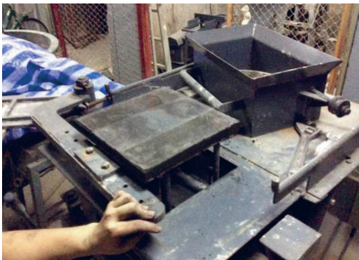
รูปที่ 7 การอัดขึ้นรูปแผ่นกระเบื้องคอนกรีตปูพื้น
