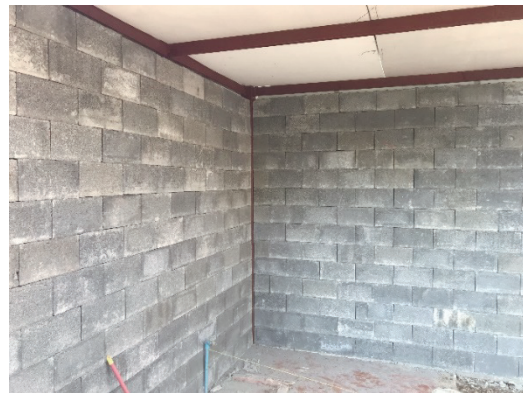
รูปที่ 17 ผนังอาคารที่ก่อด้วยคอนกรีตบล็อกเถ้าแกลบผสมเศษดินมันสำปะหลัง
