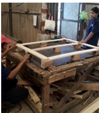
(ข) วางไม้คานประกอบล่าง
