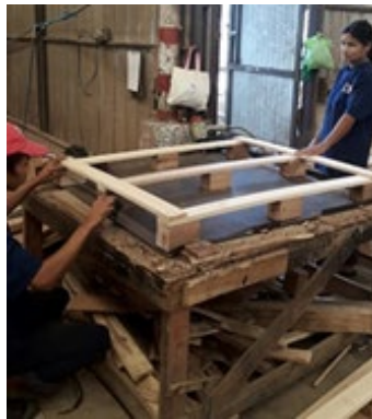
(ข) วางไม้คานประกอบล่าง
