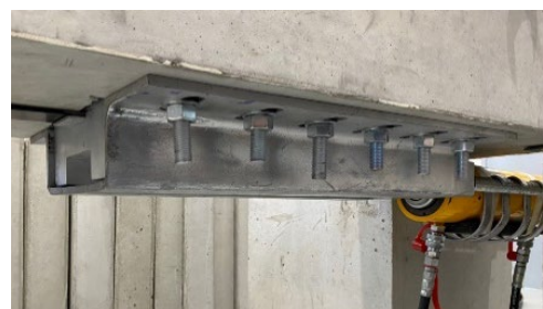
รูปที่ 4 การติดตั้งพุก อุปกรณ์สำหรับยึดรั้งแผ่น CFRP และ ไฮดรอลิกแจ๊ค (สำหรับด้านอัดแรง)
