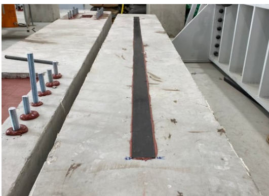
รูปที่ 5 การติดตั้งแผ่น CFRP ที่ตัวอย่าง S1-00
