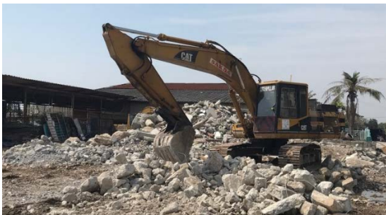
รูปที่ 1 เศษคอนกรีตจากการรื้อถอนโครงสร้างเดิม
