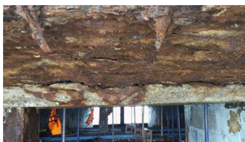
ค) สภาพการเสื่อมสภาพของเสารองรับน้ำหนักบรรทุกของอาคาร
