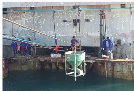
(ก) การขนส่งลำเลียงคอนกรีตช่วงที่ 1 โดยการผ่านระบบลอคในการขนส่ง (hopper)
