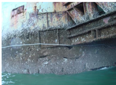
ค) สภาพการเสื่อมสภาพของเสารองรับน้ำหนักบรรทุกของอาคาร
