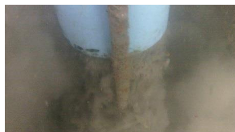
(ค) การขนส่งลำเลียงคอนกรีตช่วงที่ 3 โดยการผ่านท่อพีวีซีขนาดเส้นผ่านศูนย์กลาง 6 นิ้ว
