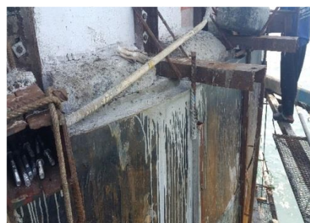
รูปที่ 14 การขนส่งลำเลียงคอนกรีตเพื่อนำไปเทเข้าแบบหล่อคอนกรีต
