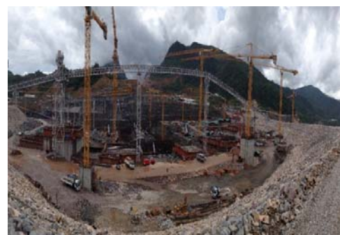
รูปที่ 19 การเทคอนกรีตของโครงสร้าง Intermediate Block
