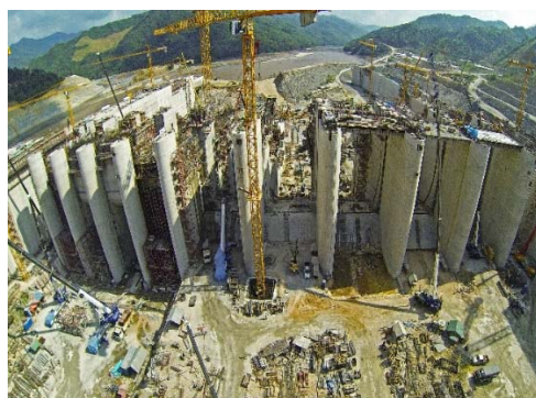
รูปที่ 18 การเทคอนกรีตของโครงสร้างทางระบายน้ำล้น
