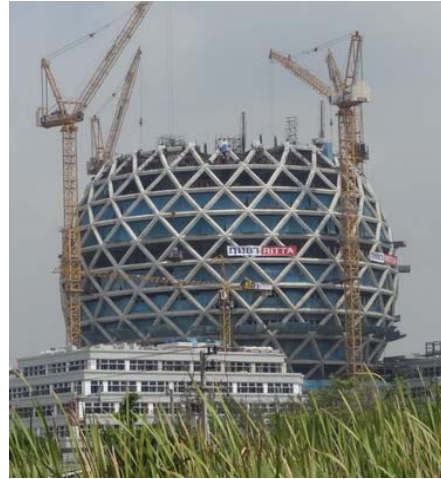
รูปที่ 28 สภาพการก่อสร้างอาคารในส่วนทรงกลม
