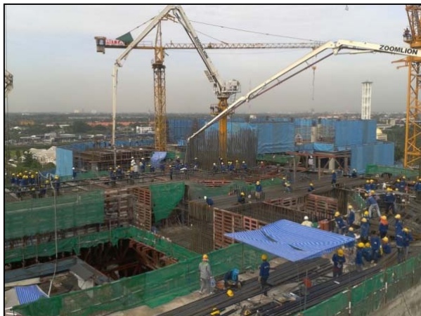
รูปที่ 12 การเทคอนกรีตหลายของพื้น-คานถ่ายน้ำหนัก ซึ่งมีความหนา 4-6 เมตร โดยใช้ระบบหล่อเย็นเช่นเดียวกับฐานรากแพ
