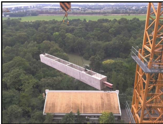
รูปที่ 30 ชิ้นส่วนคานชอยชั้นที่ 10 ที่มีช่วงยาวไม่เกิน 10 เมตร ถูกหล่อเป็นชิ้นส่วนคอนกรีตสำเร็จรูปแบบตัวเดียว เพื่อลดน้ำหนักให้ทาวเวอร์เครนสามารถยกขึ้นติดตั้งได้
