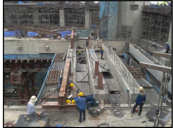
รูปที่ 31 คานชอยชั้นที่ 10 ซึ่งมีช่วงยาว 14.50 เมตร ถูกหล่อเป็นชิ้นส่วนคอนกรีตสำเร็จรูปที่ขอบอาคารด้านหนึ่ง ก่อนจะถูกเลื่อนไปบนราง เพื่อนำไปติดตั้งตามตำแหน่ง
