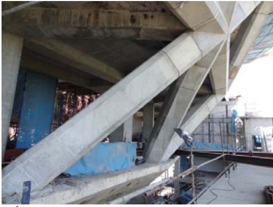
รูปที่ 27 โครงสร้างเสาเอียงและคานมีผิวเรียบและมีระนาบที่ต่อเนื่องกันอย่างสวยงาม รวมทั้งต่อเนื่องกับพื้นภายในอาคาร
