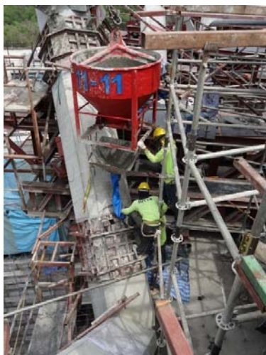
รูปที่ 24 การปิดแบบหล่อและเทคอนกรีตผ่านกรวยลงในรูที่เปิดไว้ที่ผิวบนของแบบหล่อ
