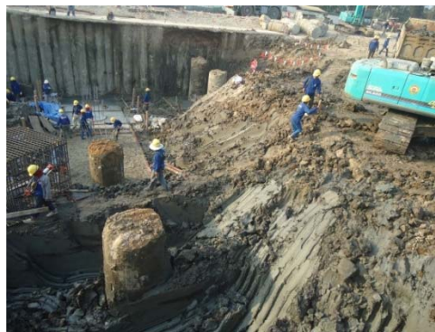
รูปที่ 2 ระบบป้องกันดินด้วยเสาดินซีเมนต์ ทำให้สามารถขุดบ่อดินลึก 4.30-7.30 เมตรได้ โดยไม่มีเหล็กค้ำยันภายในบ่อขุด
