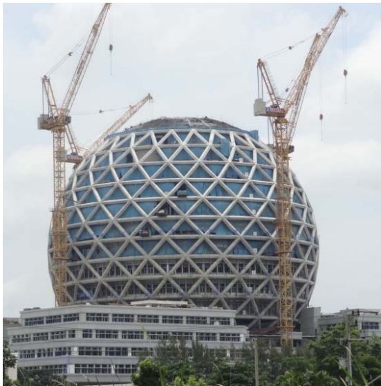
รูปที่ 33 โครงสร้างที่ผิวนอกของอาคารที่เป็นเสาถักเอียงไปตามผิวของทรงกลม
