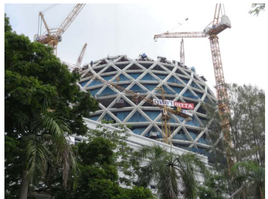
รูปที่ 20 การยกชิ้นส่วนคอนกรีตสำเร็จรูปที่มีน้ำหนักมากถึง 16 ตัน โดยใช้ทาวเวอร์เครนขนาด 540 ตัน-เมตร 4 เครื่อง ตั้งอยู่โดยรอบอาคารทรงกลม
