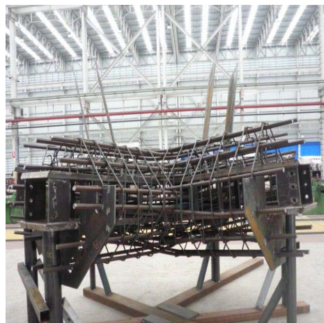
รูปที่ 25 เหล็กเสริมสำหรับชิ้นส่วนจุดต่อ Node ซึ่งมีทั้งเหล็กแผ่นและเหล็กข้ออ้อย เหล็กทุกชิ้นต้องถูกตัด ดัด แต่ง ให้ทำมุมตรงกับแบบ Bar List ก่อน นำมาประกอบเข้าด้วยกัน
