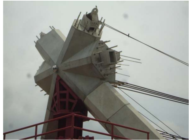
รูปที่ 22 โครงสร้างอาคารเป็นโครงสร้างประเภท Composite Section ประกอบด้วย เหล็กแผ่นกำลังสูงอยู่แกนกลาง เหล็กเสริมข้ออ้อยอยู่รอบนอก และหุ้มด้วยคอนกรีตกำลังอัดสูง
