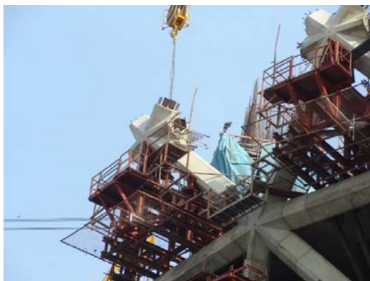
รูปที่ 19 การยกชิ้นส่วนคอนกรีตสำเร็จรูปวางบนโครงสร้างเหล็กชั่วคราว ซึ่งยื่นออกมาจากขอบอาคารประมาณ 4.50 เมตร
