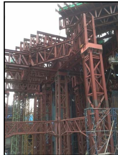
รูปที่ 14 โครงสร้างเหล็กชั่วคราวรองรับไม้แบบชั้น 6 ใช้เหล็ก
