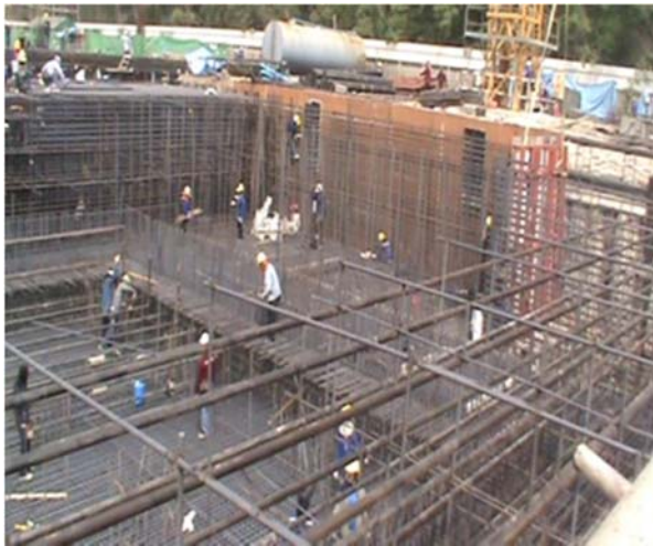
รูปที่ 5 ฐานรากแพความหนา 5.40 มม. กำลังติดตั้งเหล็กเสริมล่างและเริ่มติดตั้งงานท่อระบายความร้อนด้วยน้ำ
