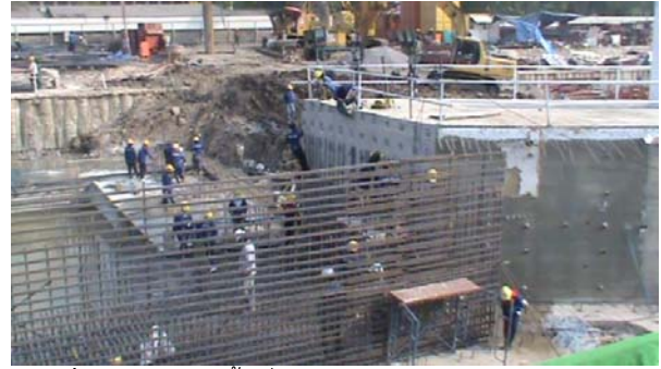
รูปที่ 9 รอยต่อแนวตั้งเพื่อแบ่งส่วนการเทคอนกรีตฐานรากแพ
