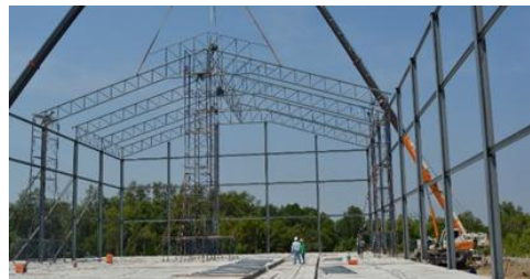
ภาพที่ 6 การใช้นั่งร้านในการขึ้นไปติดตั้งกรณีศึกษาโครงการ A(อาคาร 1) และ กรณีศึกษาโครงการ C
