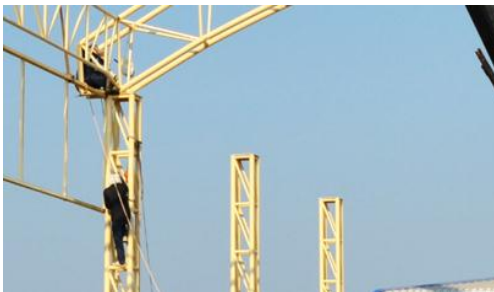
ภาพที่ 8 แสดงการปีนเสาโครงถักสามมิติเพื่อขึ้นไปทำการติดตั้งโครงหลังคากรณศึกษาโครงการ B
