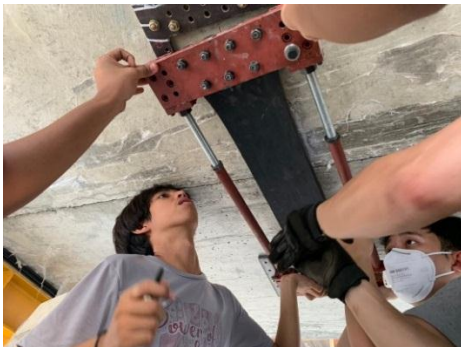
รูปที่ 5 ภาพภาพแสดงขั้นตอนการติดตั้งแผ่นยางพาราเข้ากับชิ้นส่วนสะพานสำเร็จรูป
