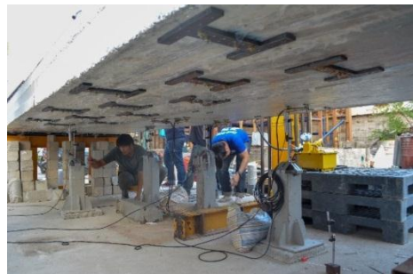
รูปที่ 4 แสดงอุปกรณ์จับยึดแผ่นยางพาราติดกับชิ้นส่วนสะพานสำเร็จรูป
