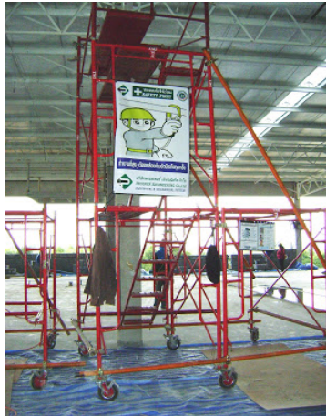
ภาพที่ 3 อุปกรณ์นั่งร้านในการปฏิบัติงาน บนที่สูง
