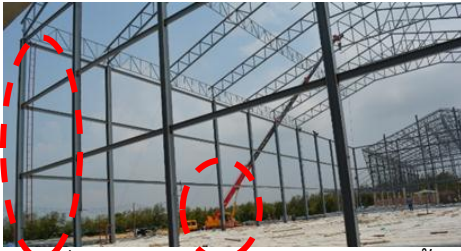
ภาพที่ 7 แสดงการใช้บันไดลิงในการขึ้นไปติดตั้งกรณศึกษาโครงการ A (อาคาร 2)
