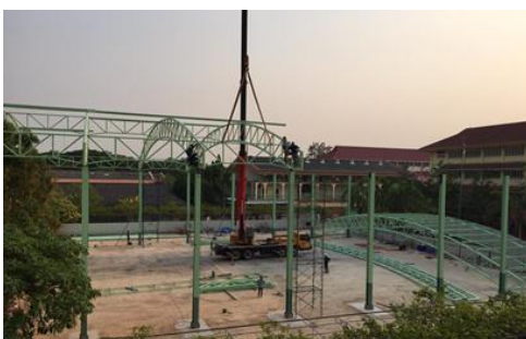
ภาพที่ 5 แสดงการติดตั้งด้วยเครน 1 คัน
