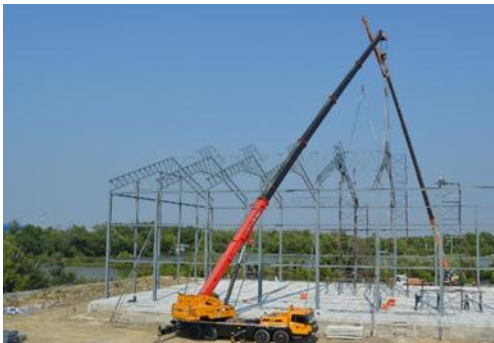
ภาพที่ 4 แสดงการติดตั้งด้วยเครน 2 คัน
