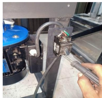
รูปที่ 7 ประกอบชุดมอเตอร์พร้อมติดตั้งเบรกเกอร์
