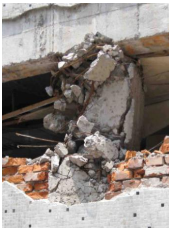
ภาพที่ 2 เสาคอนกรีตเสริมเหล็กที่ไม่ได้มาตรฐานในประเทศจีน [3]
