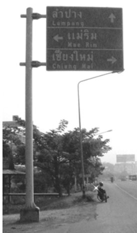
รูปที่ 1 เสาบอกทางจราจรแบบแขวนยื่น (Overhanging Traffic Sign)
