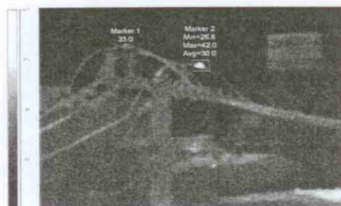
รูปที่ 3 จุดต่อทางไฟฟ้าสายป้อนหลักเข้าโรงงานอุตสาหกรรมระดับแรงดันไฟฟ้า 24 kV.
