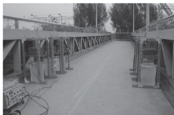
รูปที่ 1 สะพานลอยที่มีปัญหาการสั่นสะเทือนในกรุงเทพมหานคร (Poovarodom et al., 2003)
