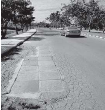
รูปที่ 8 บริเวณทดสอบพื้นคอนกรีตในถนนที่ สัญญาณจราจร
