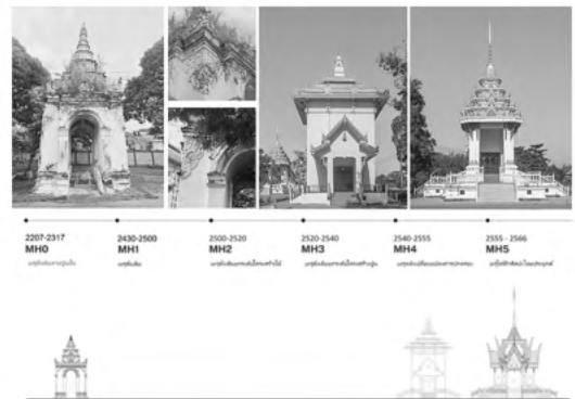
ภาพที่ 8 รูปแบบสถาปัตยกรรมเมรุ และลำดับในการก่อสร้างป่าเหี้ยวช้างคลาน
