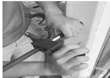
(ข) หมุนเครื่องปอกสายเคเบิล
