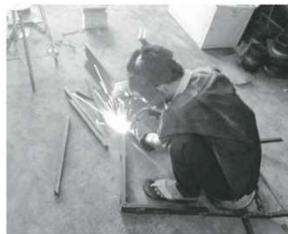
ภาพที่ 2 เชื่อมและขึ้นรูป Walker สำหรับช่วยลุกยืนของผู้สูงอายุ
