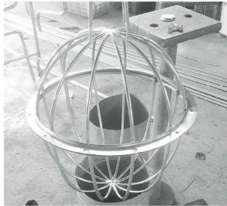
ภาพที่ 2 ทำโครงสร้างหุ่นลอย
