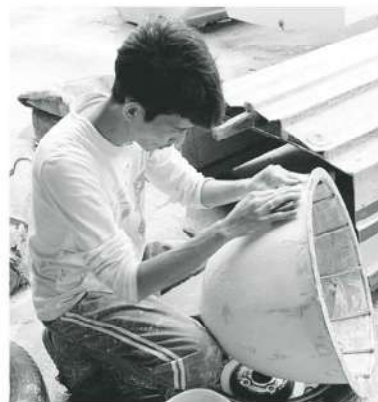
ภาพที่ 4 หล่อคาร์บอนไฟเบอร์สำหรับหุ้มโครงสร้าง
