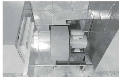
ภาพที่ 2 สร้างส่วนตู้อบและตู้เชื้อเพลิง
