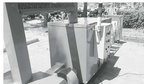
ภาพที่ 3 ติดตั้งส่วนชุดหมุนเวียนกลับ
