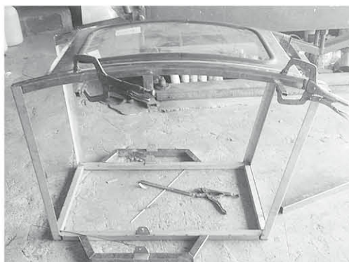
ภาพที่ 3 ติดตั้งกระจกฝาครอบถังล้าง
