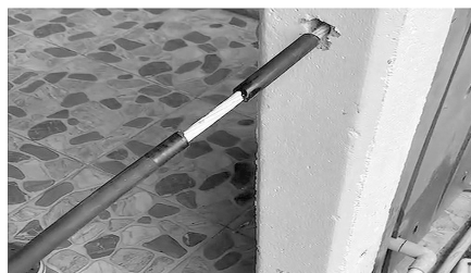
ภาพที่ 4 งานปอกสายที่ได้จากการใช้เครื่องมือปอกสายเคเบิลขนาด 50 ตร.มม.
