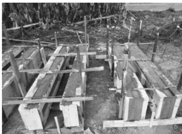
ภาพที่ 16 การประกอบแบบหล่อและเทคอนกรีตผสมน้ำยาฟารา
