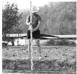
ภาพที่ 19 กำหนดความลาดของท้องคู่งน้ำโดยใช้กล้องวัดระดับ
