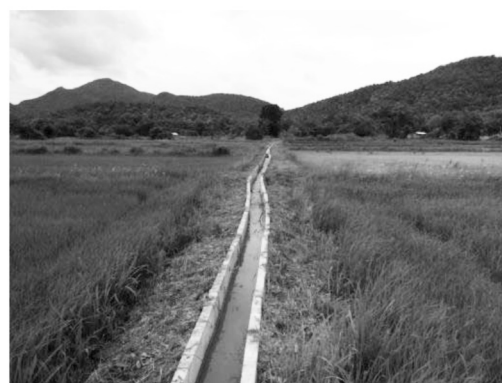
ภาพที่ 26 คูส่งน้ำหลังจากก่อสร้างและคูส่งน้ำขณะใช้งาน
