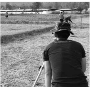
ภาพที่ 19 กำหนดความลาดของท้องคู่งน้ำโดยใช้กล้องวัดระดับ
