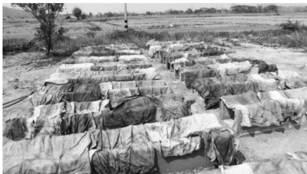
ภาพที่ 17 คู่งน้ำหลังจากที่ถอดแบบเรียบร้อยแล้วและทำการ บ่ม 28 วัน
