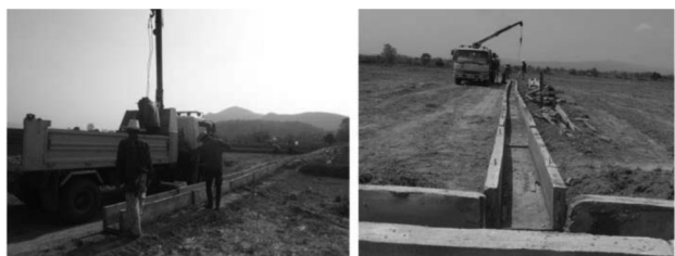
ภาพที่ 22 ตัวอย่างคูส่งน้ำสำเร็จรูปที่ได้ทำการติดตั้งในแปลงนา
