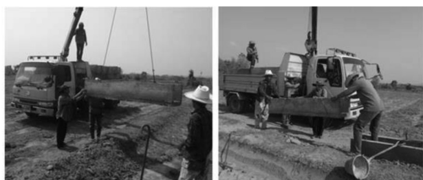
ภาพที่ 21 การติดตั้งคูส่งน้ำสำเร็จรูปผสมน้ำยางพารา
