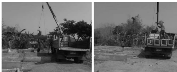
ภาพที่ 20 เคลื่อนย้ายคูส่งน้ำสำเร็จรูปด้วยรถบรรทุก
