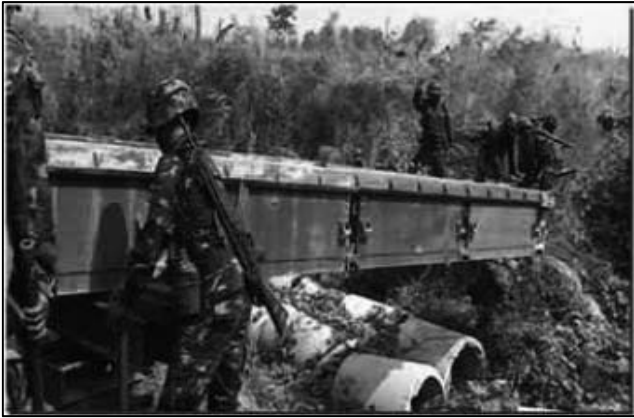
ภาพที่ 1 การเคลื่อนย้ายชิ้นส่วนประกอบของสะพาน ทหาร [3]
