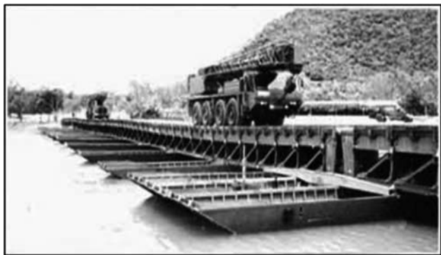
ภาพที่ 2 สะพานทหาร เอ็ม จี บี แบบโครงสองชั้น ขณะใช้งาน [3]
