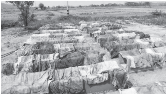
ภาพที่ 17 คูส่งน้ำหลังจากที่ถอดแบบเรียบร้อยแล้วและทำการบ่ม 28 วัน
