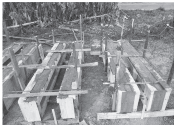
ภาพที่ 16 การประกอบแบบหล่อและเทคอนกรีตผสมน้ำยางพารา
