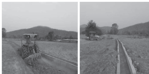
ภาพที่ 24 รถแทรกเตอร์ไถเปิดหน้าดินสำหรับทำคันคูส่งน้ำ
