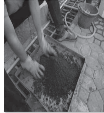
ภาพที่ 5 การผสมคอนกรีต
