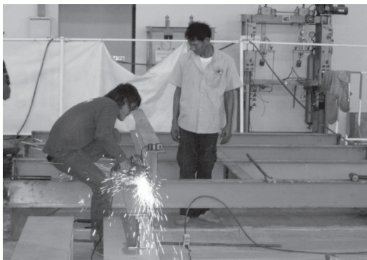
ภาพที่ 8 การประกอบสร้างโครงเหล็กเสริมต้นแบบ
