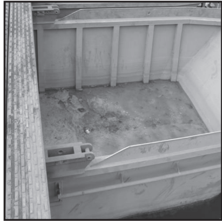
รูปที่ 3 น้ำขังในเรือทุ่นโลหะผสม สะพาน เอ็ม 4
