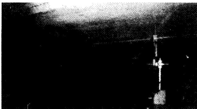
รูปที่ 11 แสดงการติดตั้ง displacement transducer ไว้ที่ท้องสะพาน
