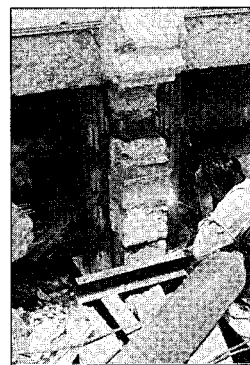
รูปที่ 16 การใช้เสาเหล็กรูปพรรณมาประกอบบนฐานรากใหม่
