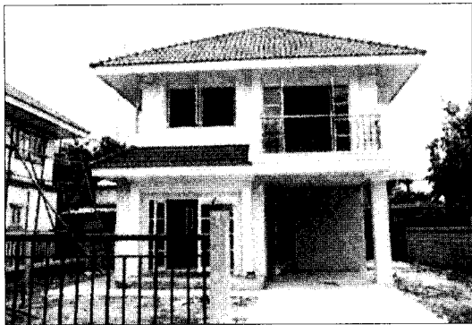
รูปที่ 14 เก็บงานสีภายนอก
