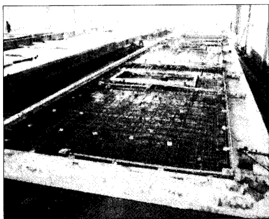
รูปที่ 5 การฝังท่อร้อยสายไฟในผนังก่อนหล่อคอนกรีต
