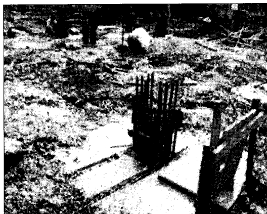
รูปที่ 15 เตรียมหล่อเสาคอม่อ
