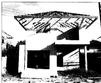
รูปที่ 11 การติดตั้งเหล็กโครงหลังคา
