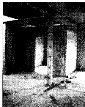
รูปที่ 12 สภาพภายในก่อนเก็บงาน
