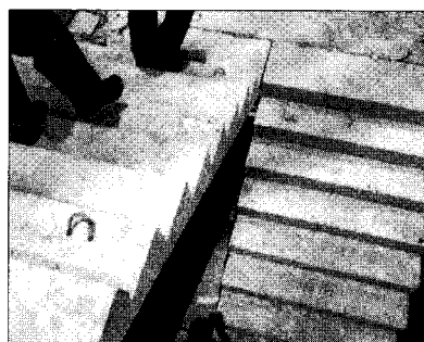
รูปที่ 10 การติดตั้งบันได
