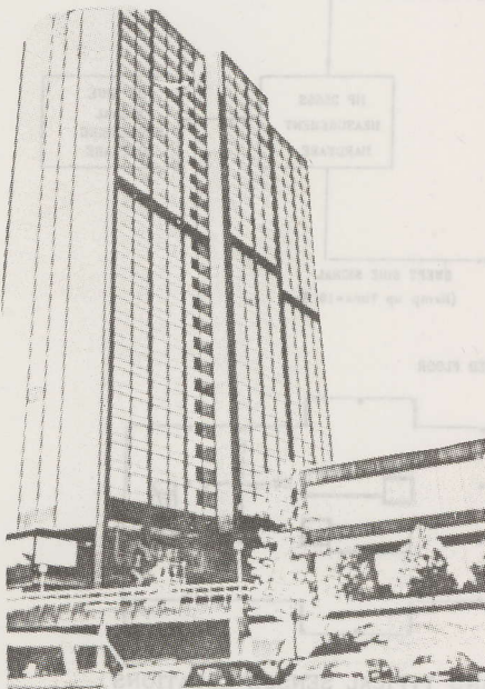
รูปที่ 5 ภาพถ่ายของอาคาร 27 ชั้น
