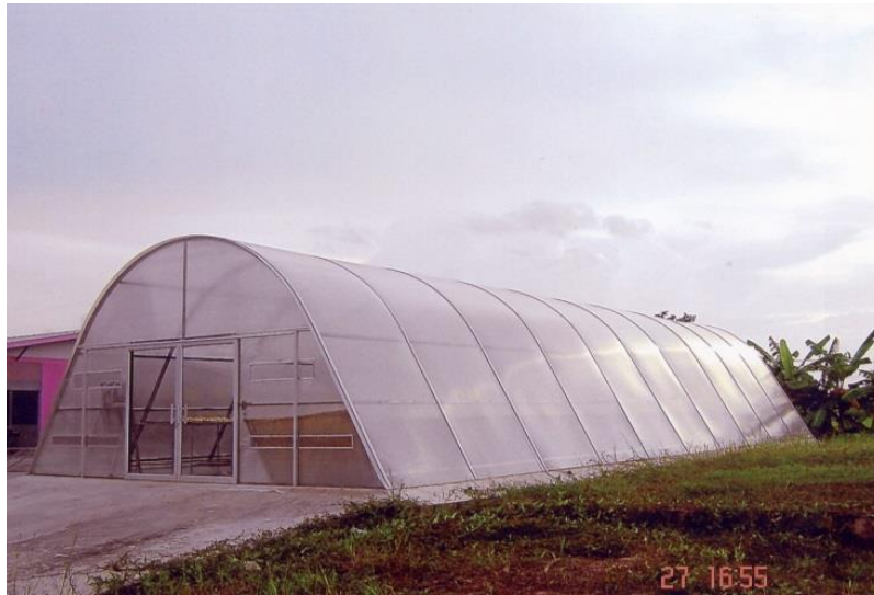
รูปที่ 5 เครื่องอบแห้งแบบพาราโบลาโดมที่ “กล้วยตากบุปผา” เมื่อปี พ.ศ. 2550
